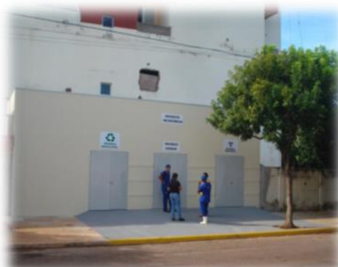
Figura 5 - Vista externa do armazenamento externo do hospital “X”
